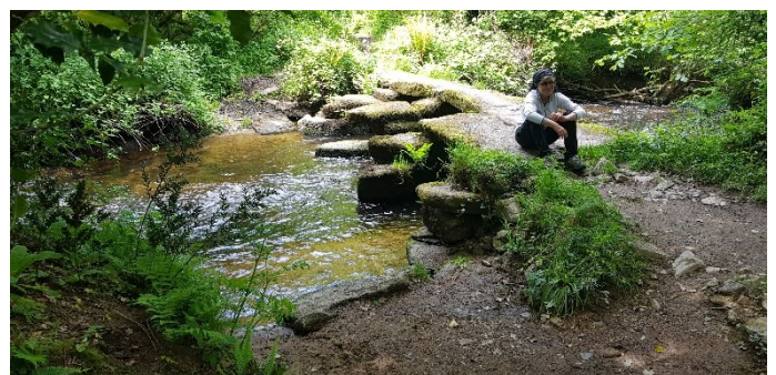
Pont de Kerporz
