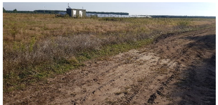
Ferme solaire de la Lucate
