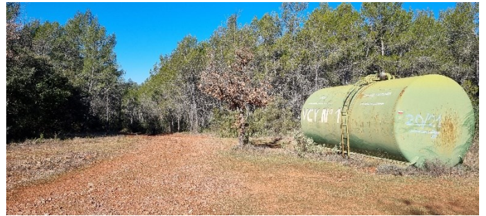
Cierne de protection incendie des Lambes
