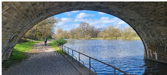
Sous le pont du chemin de fer
