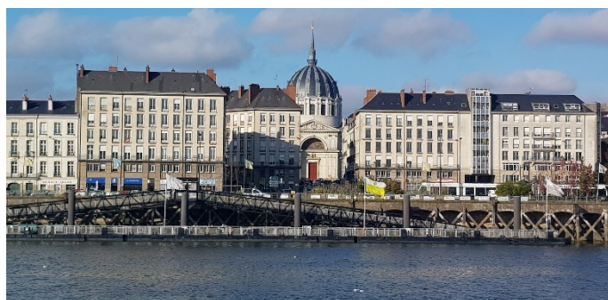
Quartier Ile de Nantes
