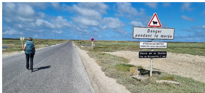
Digue submersible de Bricqueville-sur-Mer
