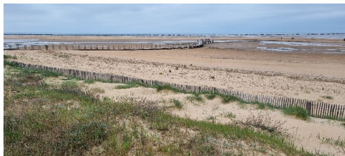
Passerelle de la Grande Casse
